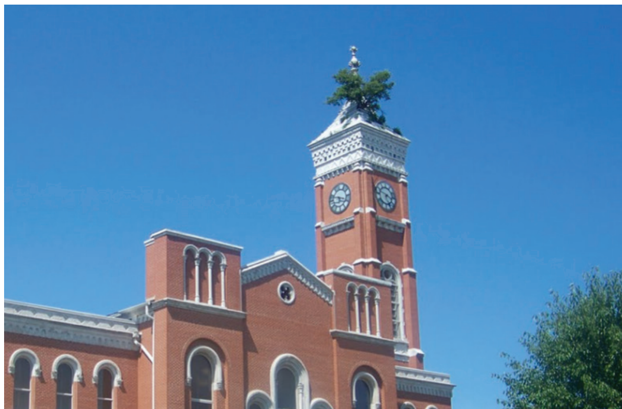
▲ 绿堡郡政府大楼楼顶上长着两颗过百岁的桑树
