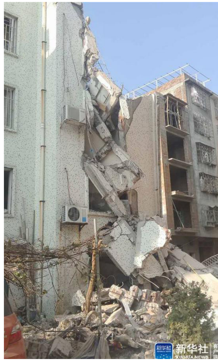
爆炸事故中一栋坍塌的居民楼。（新华社）
