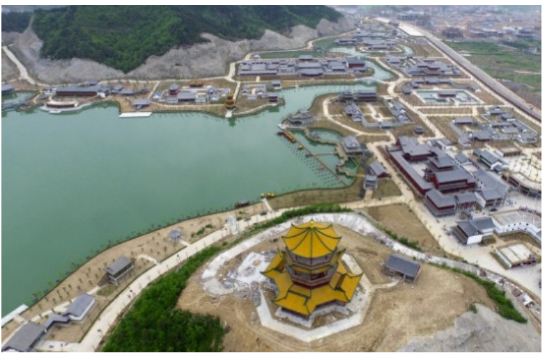
浙江东阳横店“圆明新园”，它按1:1的比例恢复了北京圆明园95%的建筑群，占地6200多亩，总投资预计300亿元，将于今年5月正式开园。(来源：中国新闻网)
